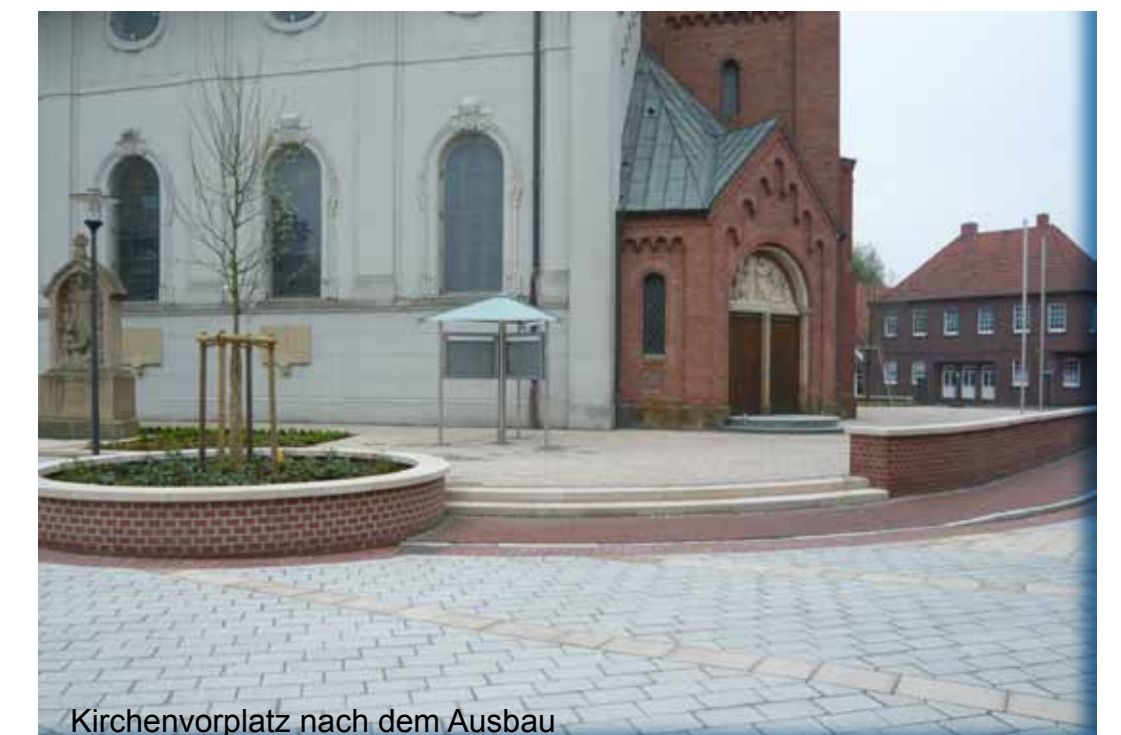
Kirchenvorplatz nach dem Ausbau
