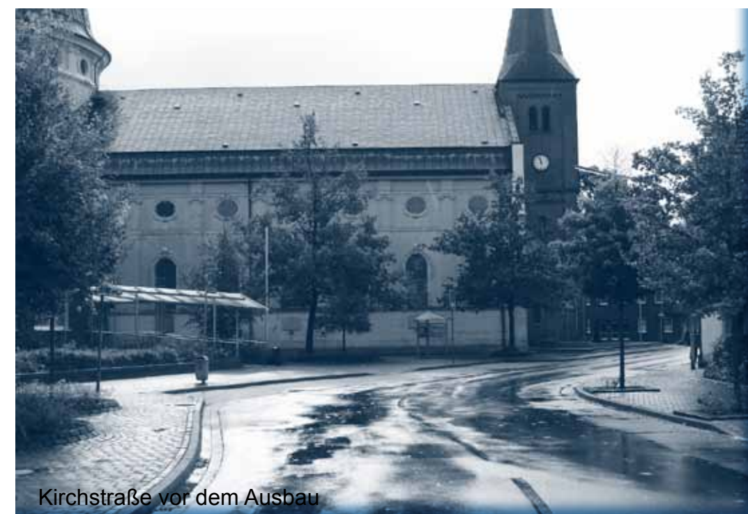
Kirchstraße vor dem Ausbau
