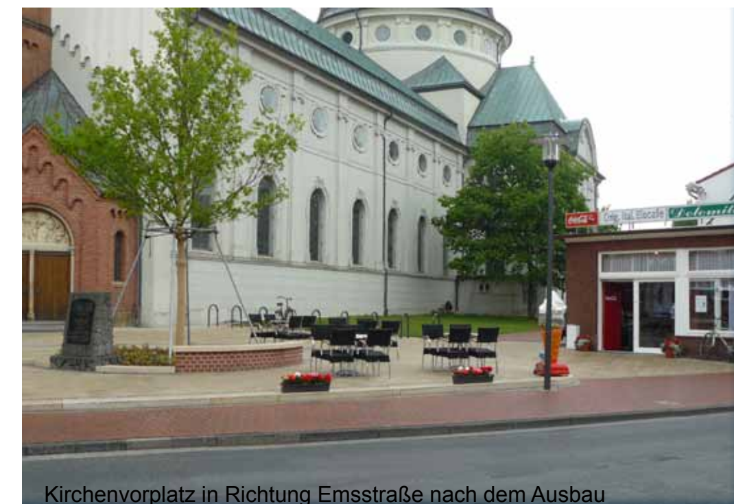
Kirchenvorplatz in Richtung Emsstraße nach dem Ausbau
