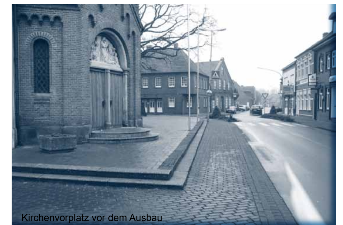
Kirchenvorplatz vor dem Ausbau
