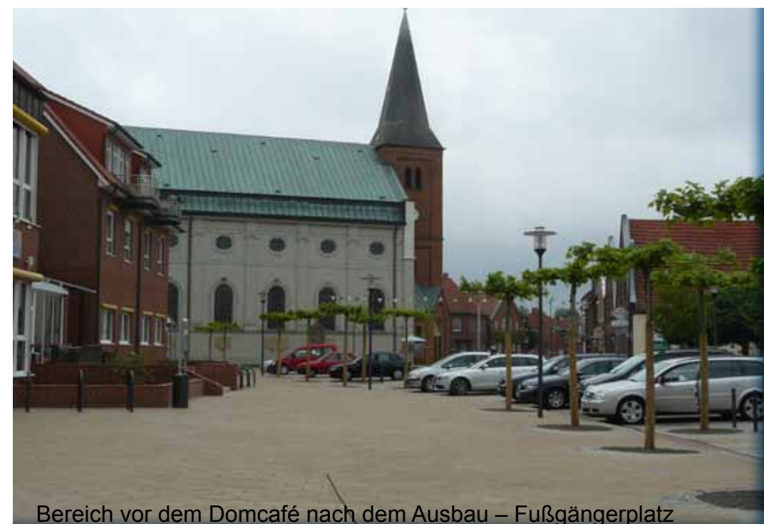
Bereich vor dem Domcafé nach dem Ausbau – Fußgängerplatz
