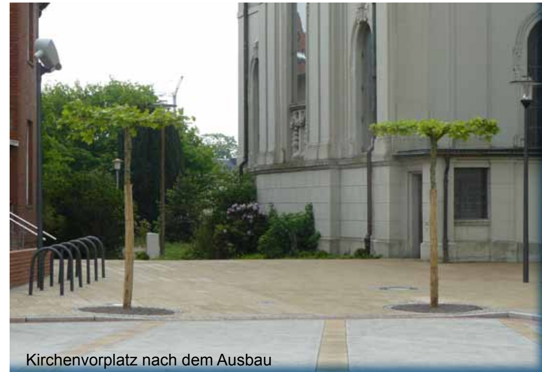
Kirchenvorplatz nach dem Ausbau
