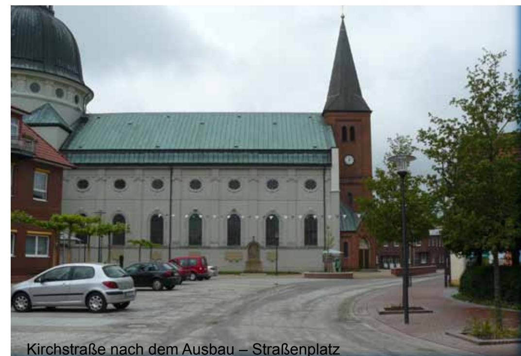
Kirchstraße nach dem Ausbau – Straßenplatz
