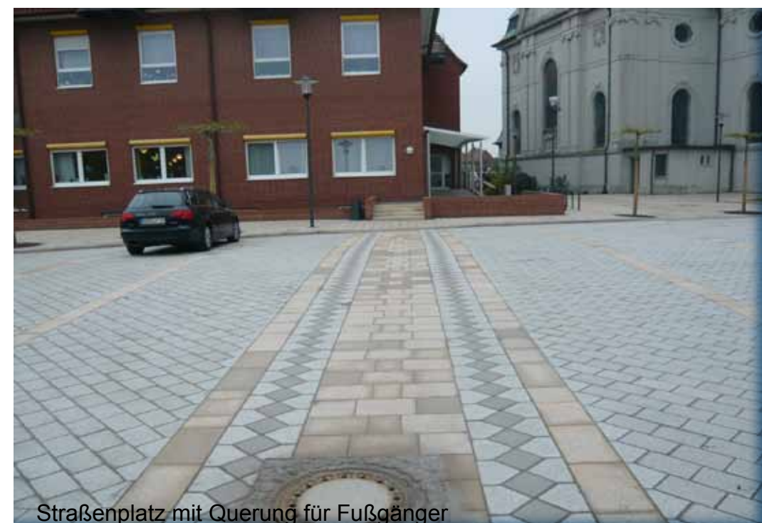
Straßenplatz mit Querung für Fußgänger
