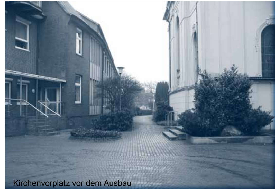
Kirchenvorplatz vor dem Ausbau
