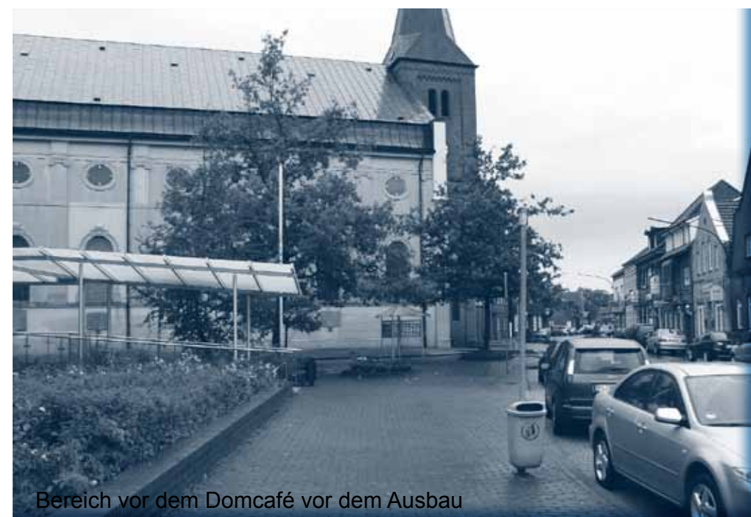
Bereich vor dem Domcafé vor dem Ausbau
